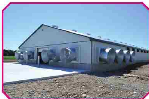
شکل ۵ وضعیت نصب هواکش‌ها و تله‌های نوری روی اینلت‌ها در سالن پرورش طیور
