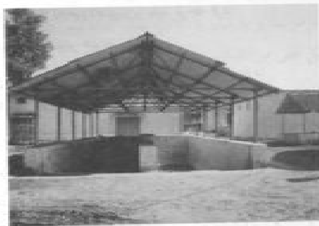
نمونه ای از سیلوی نیمه ختلی دو قلو بر پوسته
