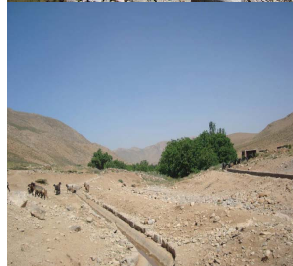
شکل ۳- نمایی از سازه‌های احداثی در حوضه بودجان
