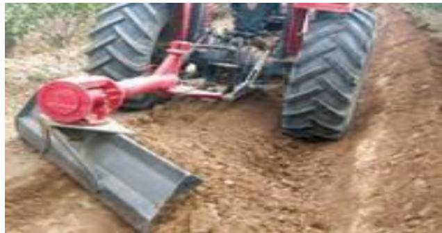
شکل ۳-۵- برطرف کردن پست و بلندی زمین قبل از عملیات خاک ورزی
